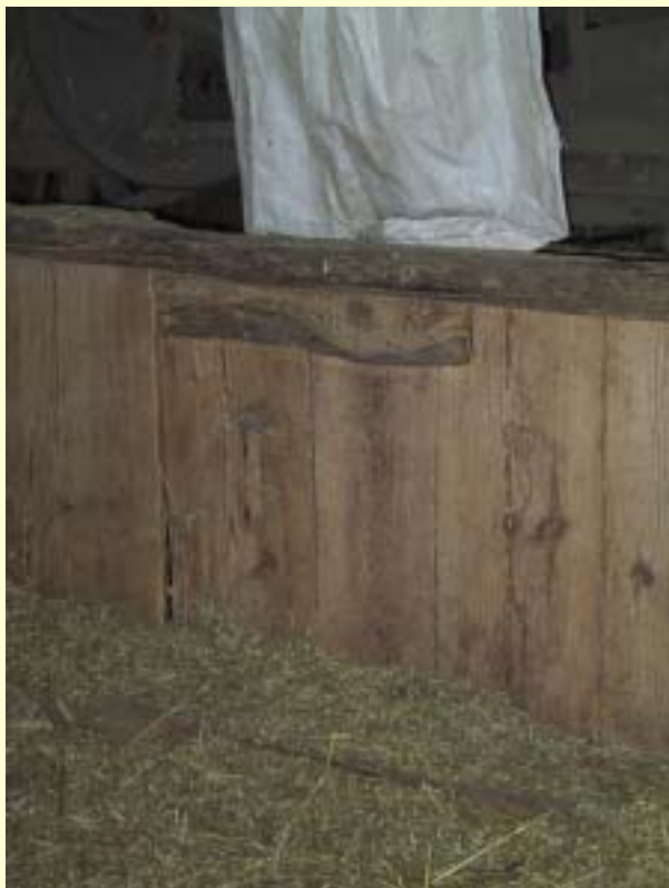
Fot. 8 Wnętrze stodoły, widoczne elementy zakonspirowanego wyjścia z bunkra.
