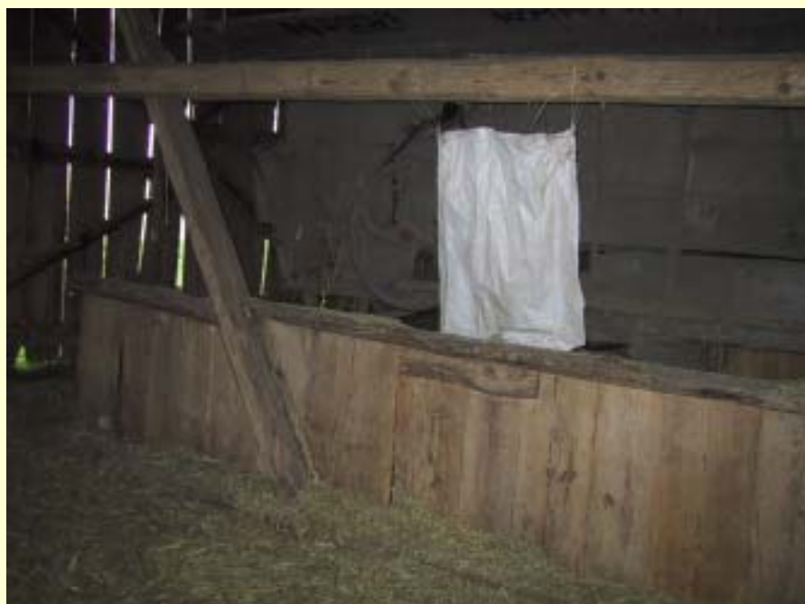
Fot. 7 Wnętrze stodoły, w której mieścił się pomocniczy bunkier bunkra „Gniazdo Gryfitów”.
